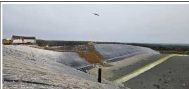
A gauche, D7.1 (avec zone de chute de déchets dans D6.3, justifiant le démarrage de la collecte de lixiviats)
